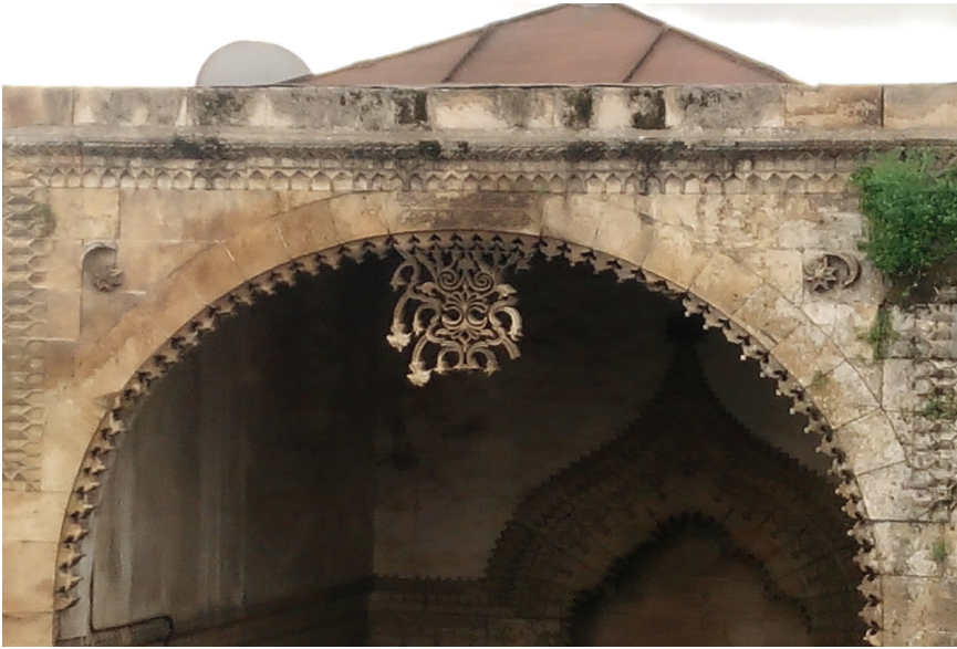
Eyvanın kemerinde oyma tekniğiyle yapılmış kilit taşı
