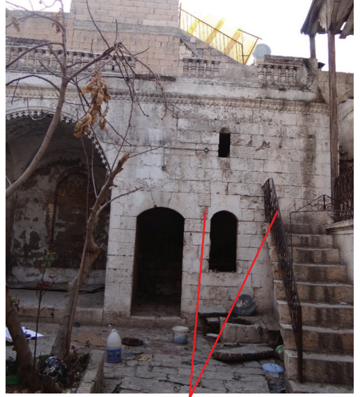
Atebe; kapı pencere üstündeki tek veya daha fazla taştan oluşa lento (Mehmet Diş Evi 2014).
