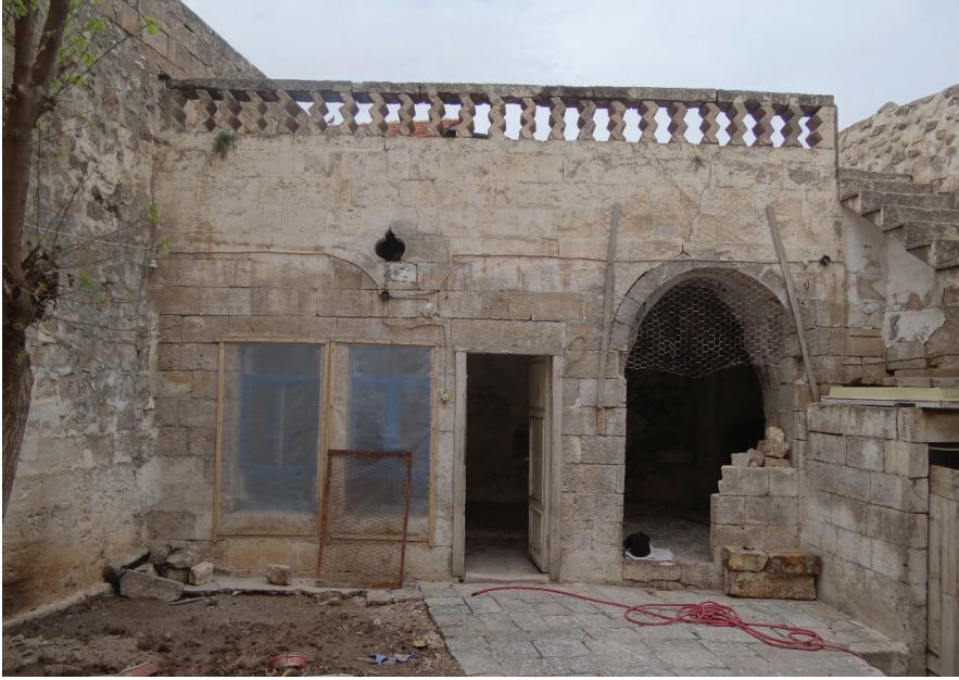
Kapı ve pencere  stlerinde a ıklığı ge mek i in kullanılmı  olan "tek"ler (Mehmet Di  Evi 2014)
