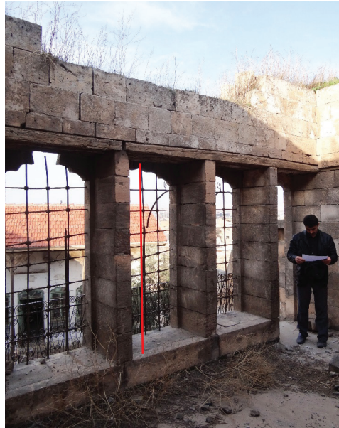
Kelp (pencere takılması i in bırakılan di )(Mehmet Di  Evi 2014)
