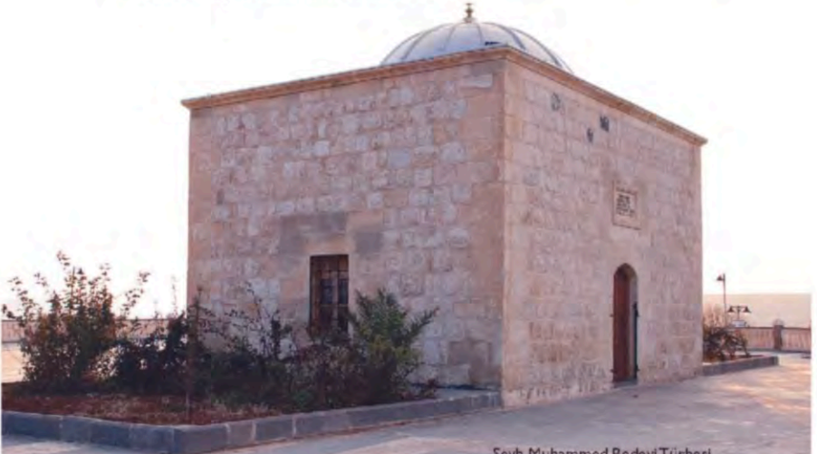
Şeyh Muhammed Bedevi Türbesi
